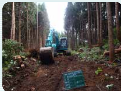
イヌワシの採餌環境に配慮した作業道整備
