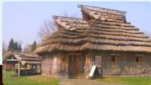
アイヌの伝統家屋「チセ」 建設資材として社有林材を一部供給
